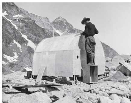
Fasi di montaggio di un bivacco tipo Ravelli Archivio Museo Nazionale della Montagna - CAI Torino
