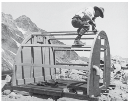
Fasi di montaggio di un bivacco tipo Ravelli Archivio Museo Nazionale della Montagna - CAI Torino
