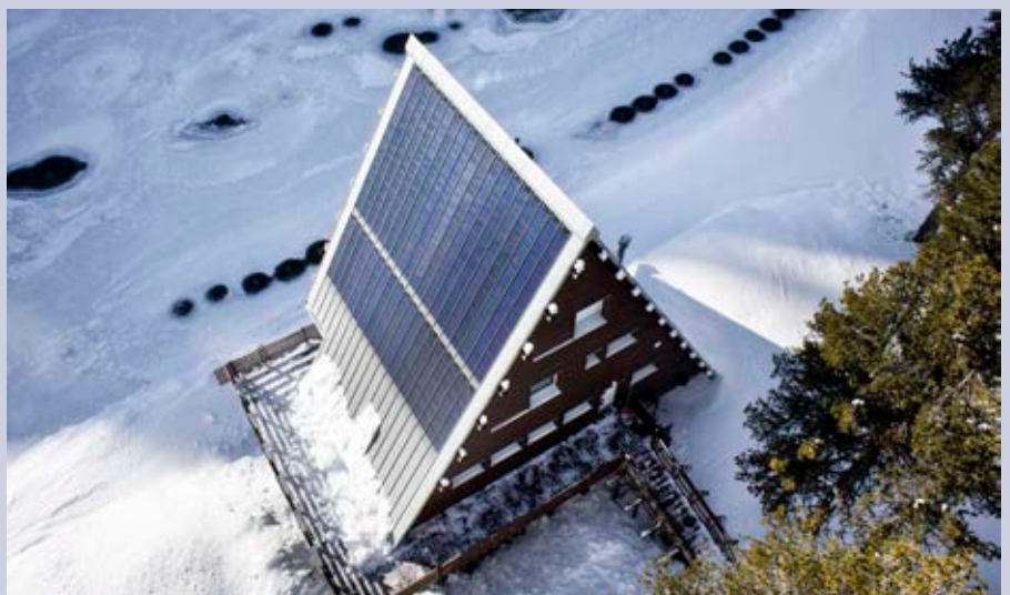
Rifugio Carlo Mollino, DAD - Politecnico di Torino, su progetto originale di Carlo Mollino, "Casa Capriata"; Weissmatten, (Gressoney Saint Jean-AO), 2050 m, 2014
